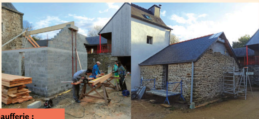
Maison des artistes : rénovation complète
