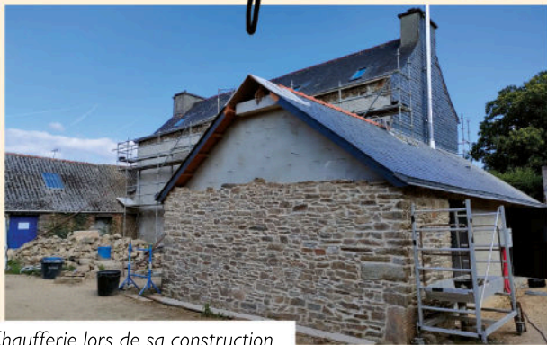
Chaufferie lors de sa construction
